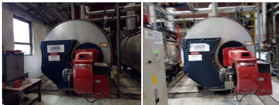
Slika 8. – Kotlovi proizvođača Loos international tip ECO1
