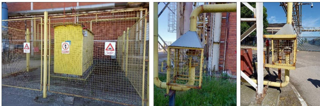
Slika 9. - Nova merno regulaciona stanica sa gasnim instalacijama
